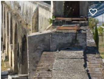
Aqueduto da Amoreira
